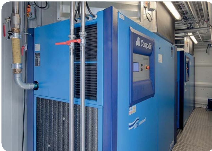
Drei drehzahlgeregelte 75 kW-Kompressoren erzeugen die im GKD-Werk benötigte Druckluft.
