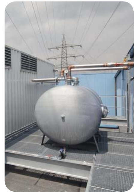
Auch der Speicherbehälter wurde auf dem Dach installiert.
